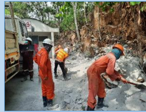
การทำแนวกันไฟรอบคลังวัตถุระเบิด โดยใช้ปูนล้างไซโล มาโรยรอบๆแล้วรดน้ำ
