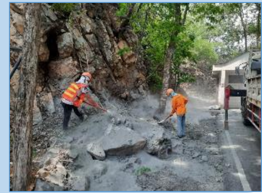
การทำแนวกันไฟรอบคลังวัตถุระเบิด โดยใช้ปูนล้างไซโล มาโรยรอบๆแล้วรดน้ำ
