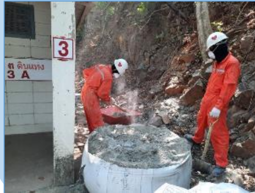
การทำแนวกันไฟรอบคลังวัตถุระเบิด โดยใช้ปูนล้างไซโล มาโรยรอบๆแล้วรดน้ำ
